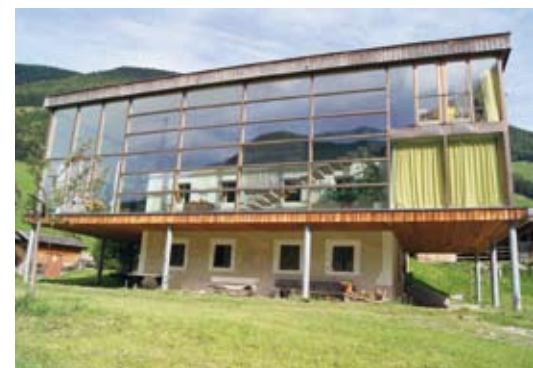
FOTO SOPRA Per rendere più confortevole e spazioso il vecchio maso è stata realizzata una nuova struttura a vetri che circonda letteralmente l'edificio preesistente
